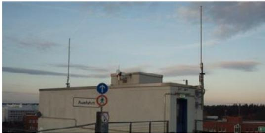
Bild 1 und 2: verschiedene Rundstrahlantennen (J. Pause, Vodafone)
