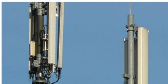
Bild 3 und 4: Verschiedene Sektorantennen (J. Pause, Vodafone)
